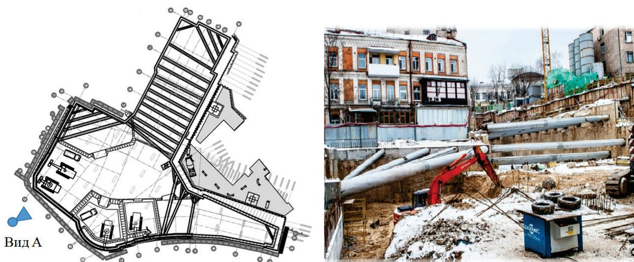
**Рис.1 Производство работ по ограждению котлована в блоке В:
